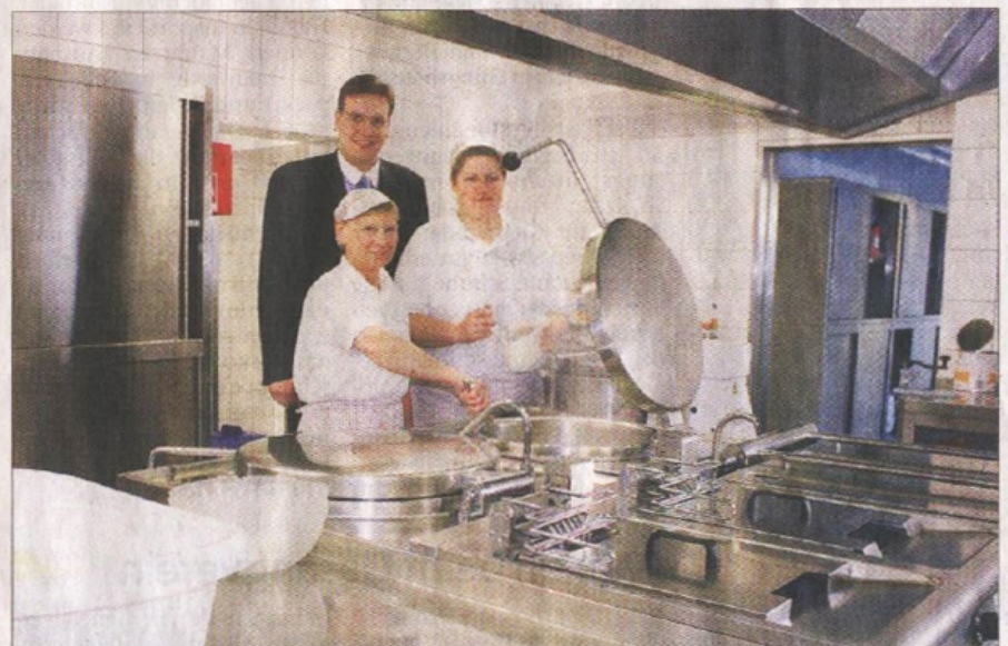
Rund 60 000 Euro wurden in die Küche des „Heiligenhofs“ investiert. Sie präsentiert sich jetzt chromglänzend und auf dem neuesten Stand der Technik. Das freut nicht nur die Hauswirtschaftsmeisterinnen Liselotte Zureck (links) und Petra Schneider (rechts), sondern auch Geschäftsführer Steffen Hörbler. Foto: Bartl
