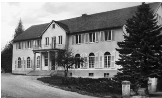
Der Heiligenhof erhält ein ausgebautes Oberstockwerk.
